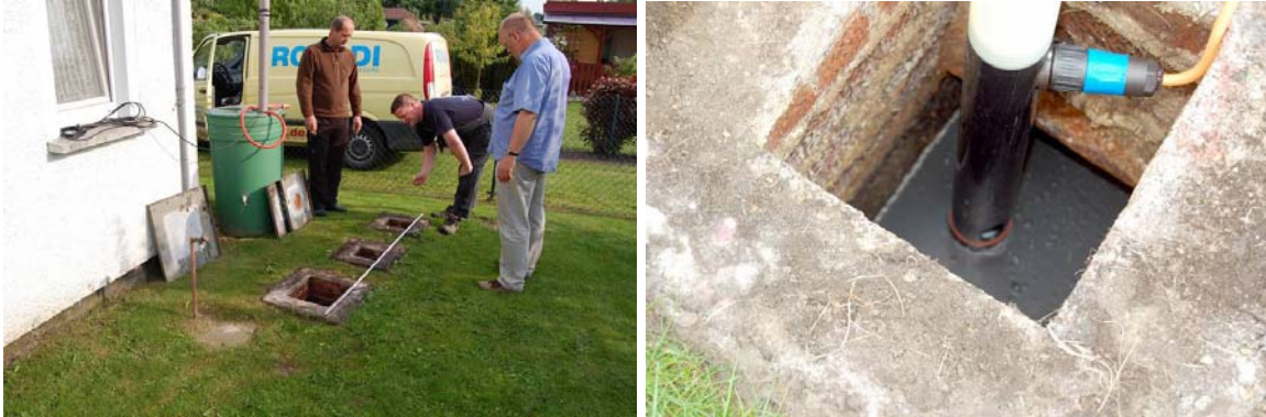
Abbildung 3: links: Dreikammergrube aus Mauerwerk /VGF-HRO 2010/ rechts: Detailaufnahme eines Behälters /VGF-HRO 2010/
