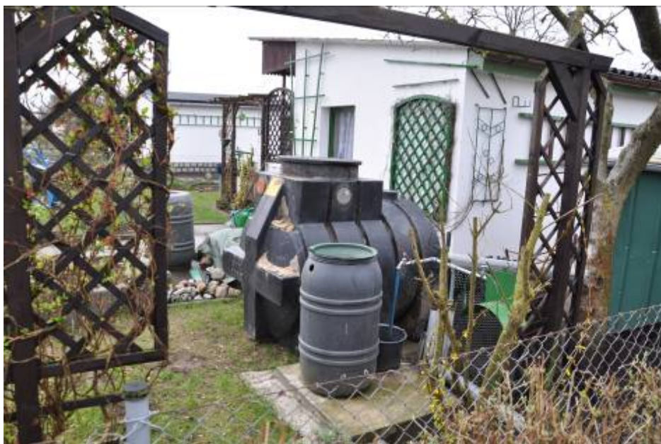
Abbildung 4: Sammelgrube aus PE (Bildquelle: Gürcke)
